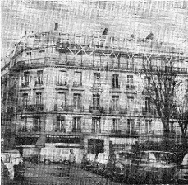
VISTA GENERAL DE LA CASA DE CUERVO en la esquina de la Rue de Siam con la Rue Mignard. En los últimos pisos se observan andamios para trabajos de reparación y enlucimiento.
