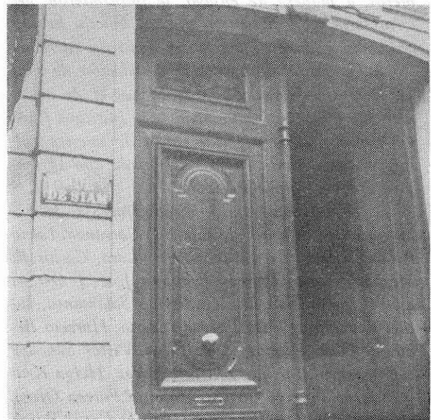
PORTON DE LA CASA DE CUERVO Obsérvese la placa de nomenclatura urbana.
