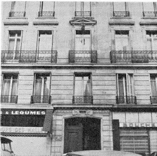
FACHADA DE LA CASA DE CUERVO y portón sobre la Rue de Siam.
