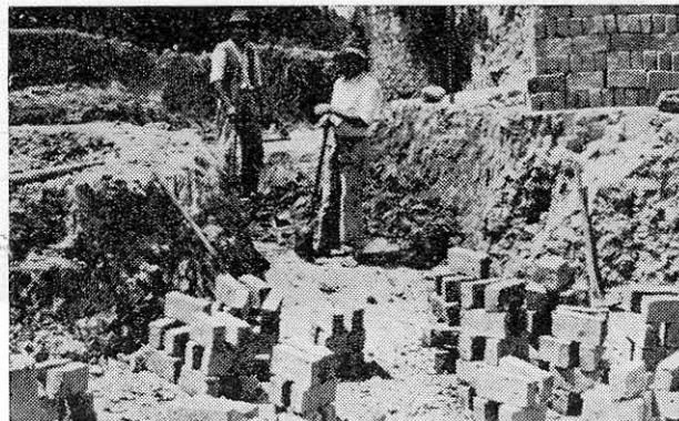
Obreros fabricando ladrillo en un chircal de Tibaná, industria frecuente en la región.
