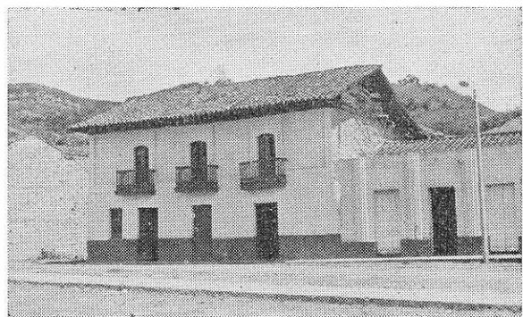
CHITARAQUE. — En el marco de la plaza forma esquina esta habitación de balcones salidos y de estilo antiguo, con techo de teja de barro, que se ha tratado de disimular en la casa contigua a la que se ha querido dar un tinte moderno. Es fuerte el contraste de estilo en las construcciones.
