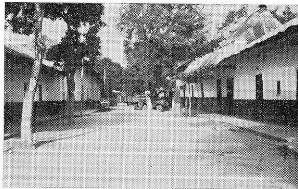
Las techumbres de zinc son las de las habitaciones en esta calle principal de Coello, sombreada por los árboles, que han quedado dentro de la calzada, al parecer por la ampliación de la vía.
