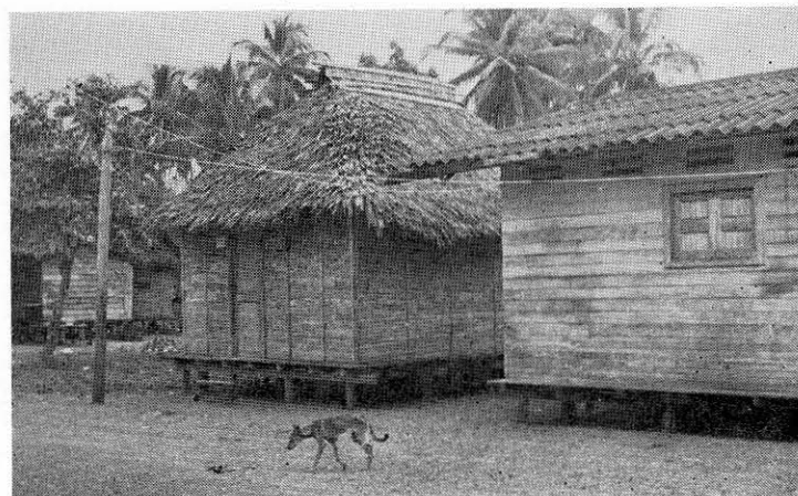
ARUSÍ. — Casa de la Inspección de Policía Departamental.
