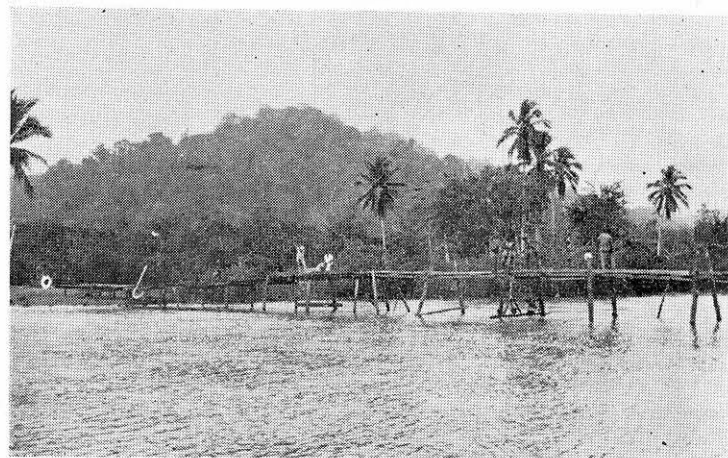
PUERTO MUTIS. — Puente de madera sobre el río Jella.
