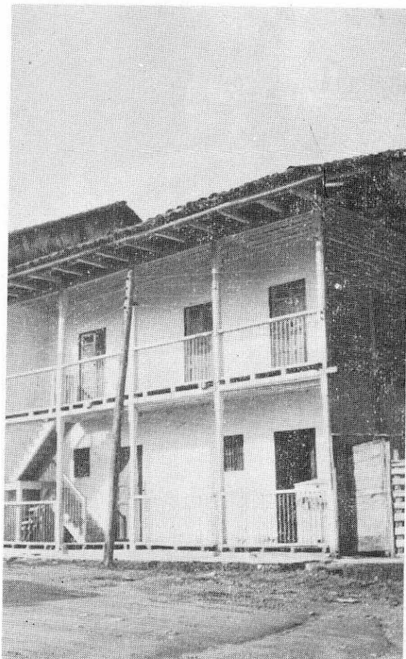
MOCOA. — Barandas y escaleras exteriores en una casa de dos pisos.
