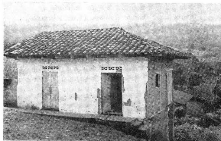
Este es un tipo de casa tradicional en Mocoa: un solo piso y techo cubierto con tejas de barro.
