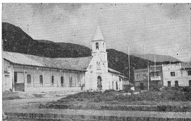
TÓPAGA. — Iglesia y casa cural. La primera, construída por los jesuítas. Estos tuvieron allí un centro de recuperación para los misioneros de Casanare.
