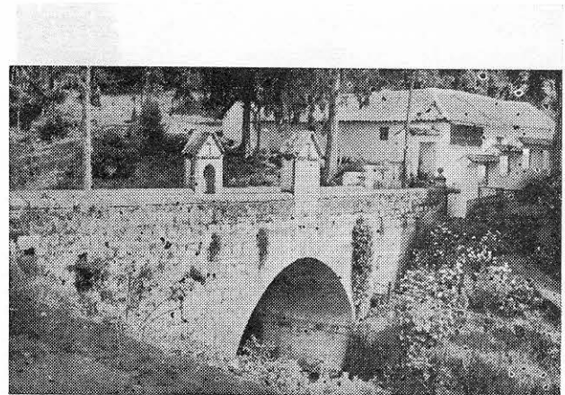
MONGUÍ. — Puente colonial de calicanto, en la salida hacia Morcá. Tiene fecha de mayo de 1715 y aún se mantiene en servicio, sin mayor alteración.
