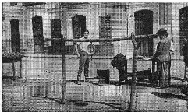
CORRALES. — "Peso" de la carne, en la plaza, en un día que no es de mercado. Está colgado de una vara horizontal sostenida en los extremos por dos horquetas clavadas en la tierra.
