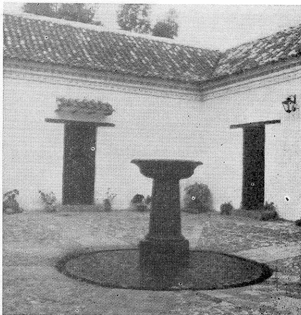
Museo y monumento nacional en Villa de Leiva, es la casa del héroe Antonio Ricaurte (1786-1814). En este ángulo se pueden observar detalles de armónica arquitectura colonial, en la cubierta general, de teja de barro cocido; en el alero sobre la puerta con esa misma clase de entejado; en el farolillo y en la pila de piedra labrada.
