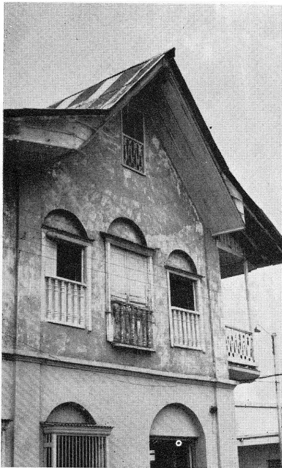
SAHAGÚN. — Tipo de techo y ventanas.
