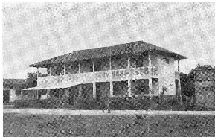
TAURAMENA. — Tipo de casa de dos pisos, único en la población.
